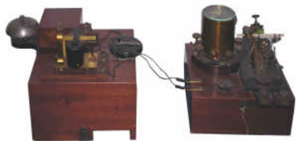
Uno dei primi ricevitori a coherer realizzati da Marconi
